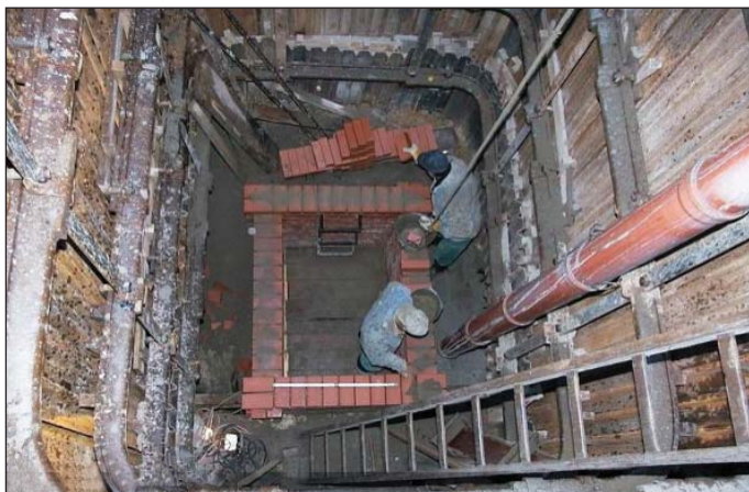
Obr. 1 Šachta vyztužená ocelovou důlní výztuží Fig. 1 Shaft reinforced with steel colliery support
