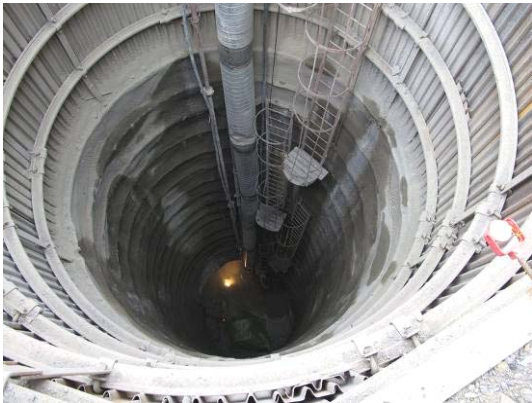
Obr. 4 Poddajná konstrukce šachty
