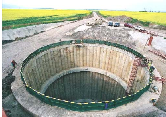
Obr. 5 Tuhá konstrukce šachty [12]
