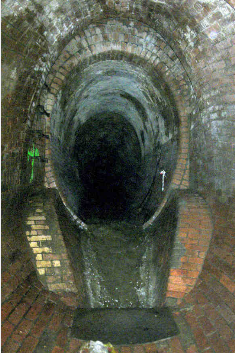
▲ Obr. 2. Původní odlehčovací komora, tzv. žabí tlama
