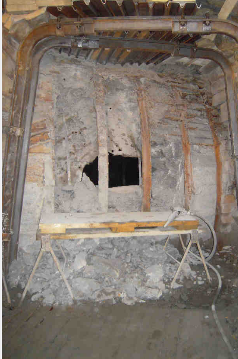
▲ Obr. 10. Výstavba propoje do stoky K
